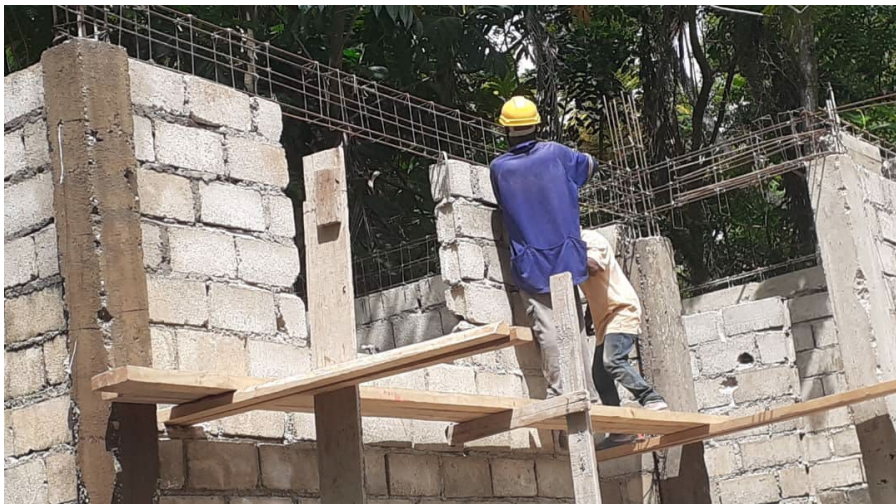
Bau von Toilettenanlagen in Haiti
